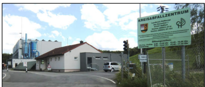
Abbildung 26: Einfahrt Deponie Wonfurt
